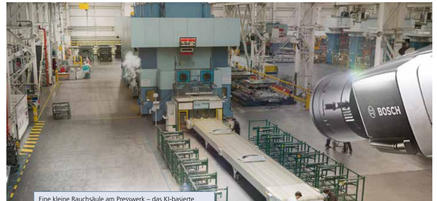
Eine kleine Rauchsäule am Presswerk – das KI-basierte Branderkennungssystem AVIOTEC erkennt sie sofort.
